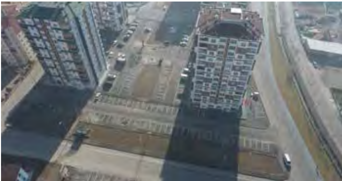
Muhtelif Mahallelerde Park ve Çevre Düzenlemesi İşİ Sözleşme Bedeli:811.393,50 TL
