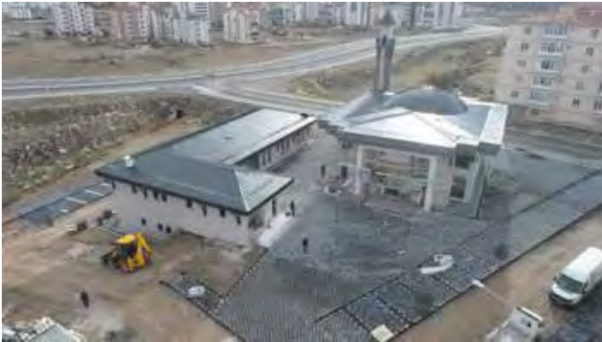
Kahraman Çelebi Cami ve Hatice Çelebi Diyanet Eğitim ve Kültür Merkezi Yapımı İşİ Sözleşme Bedeli: 2.479.500,00 TL
