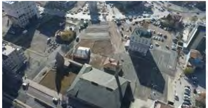
Tacettinveli Mahallesi Çevre Düzenlemesi Yapılması İşİ Sözleşme Bedeli:740.238,00 TL
