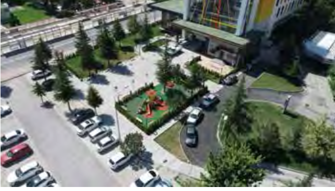
Erciyes Üniversitesi Çocuk Hastanesi Çevre Düzenlemesi Yapımı İşİ Sözleşme Bedeli: 360.029,53 TL
