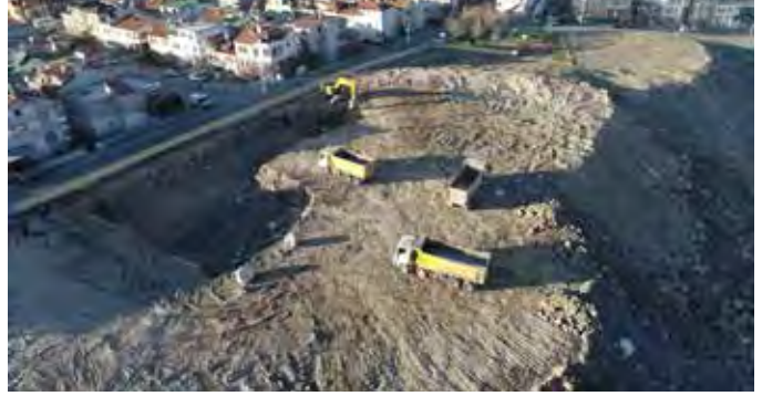
Esenyurt Mahallesi 24 Derslikli Ortaokul Yapımı İşİ Sözleşme Bedeli: 13.788.000,00 TL
