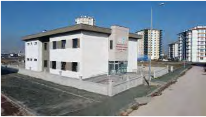
Anbar Mahallesi 7072 Ada 1 Parsele Aile Sağlığı Merkezi Yapılması İşİ Sözleşme Bedeli : 3.268.000,00 TL
