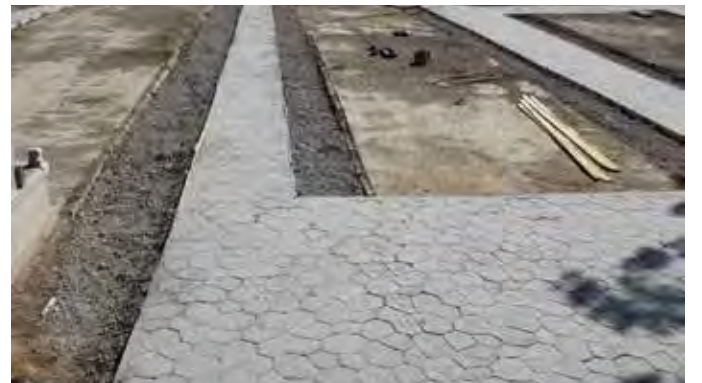
2022 Yılı Muhtelif Mezarlıklarda Çevre Düzenlemesi ve Duvar Yapılması İşİ
