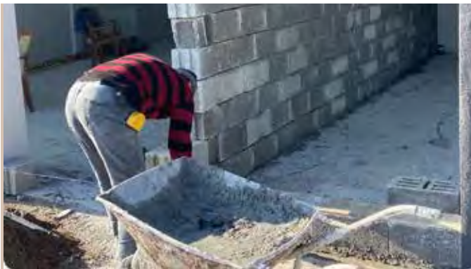
Melikgazi İlçesi Kazımkarabekir Mahallesi Dükkan Tadilatı İşİ
